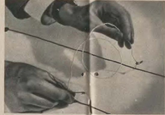
A nyomógomb-vezeték áthidalása
