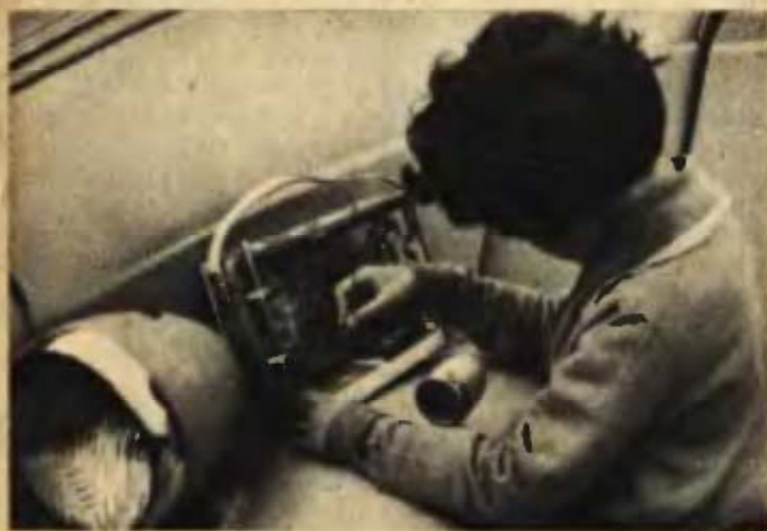
7. ábra. Oriántonból kivesszük a telepeket
