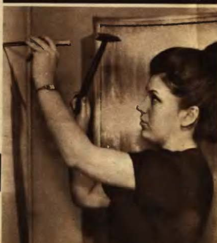
Kisebb tárgyak felfüggesztéséhez a tiplibe különféle menetes csavarok is behajthatók
