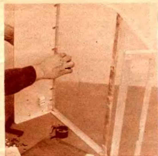
A burkolólemezeket így csavarozzuk fel
