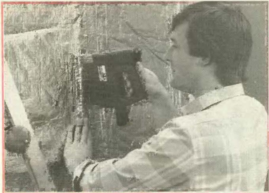
3. A vékonyabb szigetelő táblák, paplanok felerősítésére kiválóan alkalmas – hosszú U szegekkel – a tűzgép.
