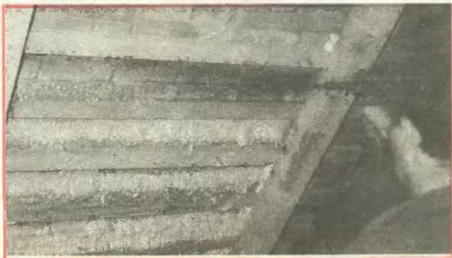
4. Cseréphéjalást és a tetőszéket a belső szigetelés előtt gondosan rendezni és rögzíteni kell. Erre kitűnő a PUR-hab belülről felszórása.
