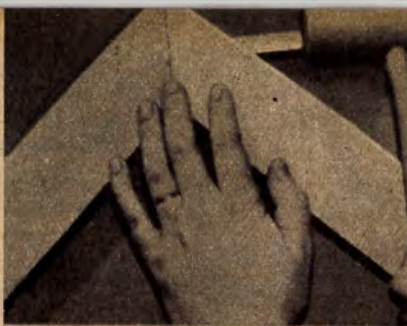
Derékszögű illesztések megerősítésére beeresztett és beenyvezett facsapot is használhatunk. A csapnak mindkét összeillesztett alkatrészen át kell hatolnia.
