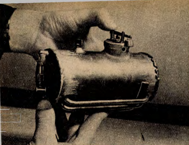
A kész kazántest a gőzgyűjtő dómmal és a biztosító szeleppel. Felül a beöntőnyílás, elől a vízállás-mutató, a leeresztőnyílás, alul pedig a vízcsovek láthatók
