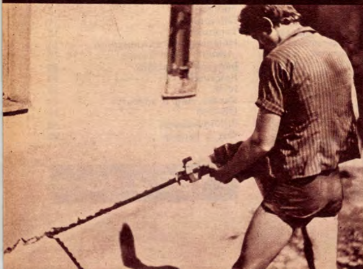
Készül a furat az elektródák (fémrudak) befogadására
