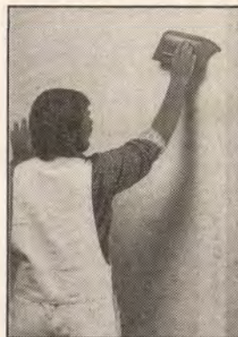
D ábra Burkolólap simítása műanyag lappal
