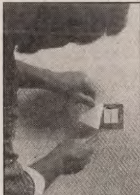
G ábra Elektromos kapcsolók helyének kivágása
