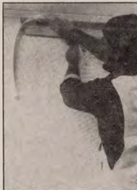
F ábra Burkolólapok méretre vágása alul és felül
