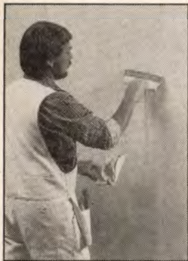
A ábra Falfelület glettelése
