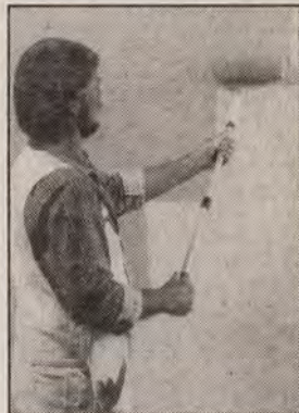
H ábra A felület festése két rétegben
