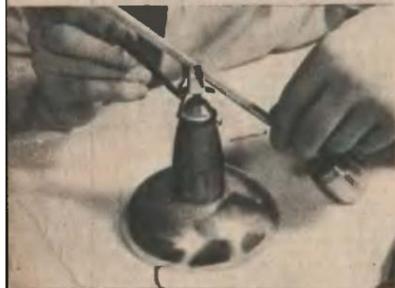
A forgózsámolyt csapszeg köti össze a fémcsővel; a képen látszik a csőből kibújó huzalvég, ezt az áramleszedő rugóhoz forrasztjuk. Az áramleszedő rugó ne legyen túl feszes, mert különben lefékelt a szerkezetet
