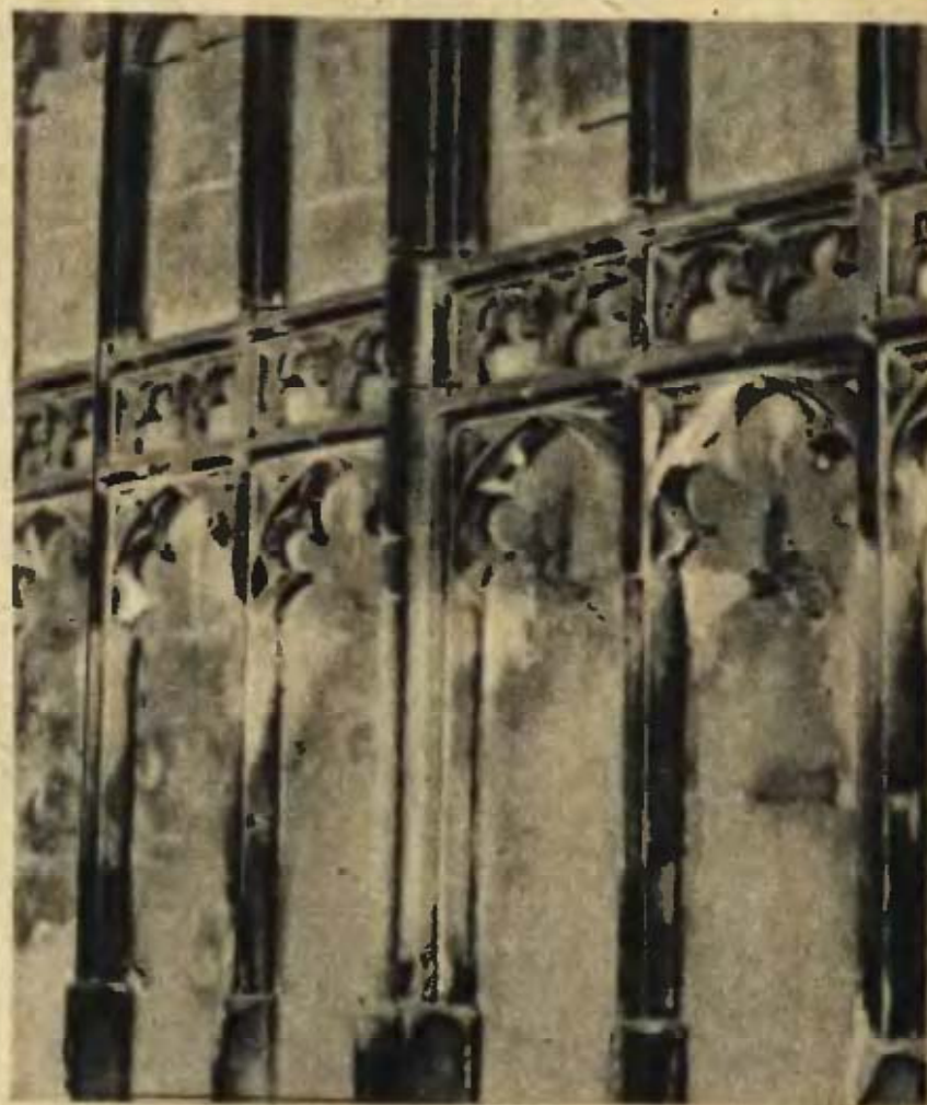
A Gloucesteri Katedrális fala. Az angol Rentokli Vállalat a magyar mérnökök eljárásával mentette meg a műemléket. Az elektromos rövidrezárással alkalmazása után 1 év alatt tökéletesen kiszáradt az épület
