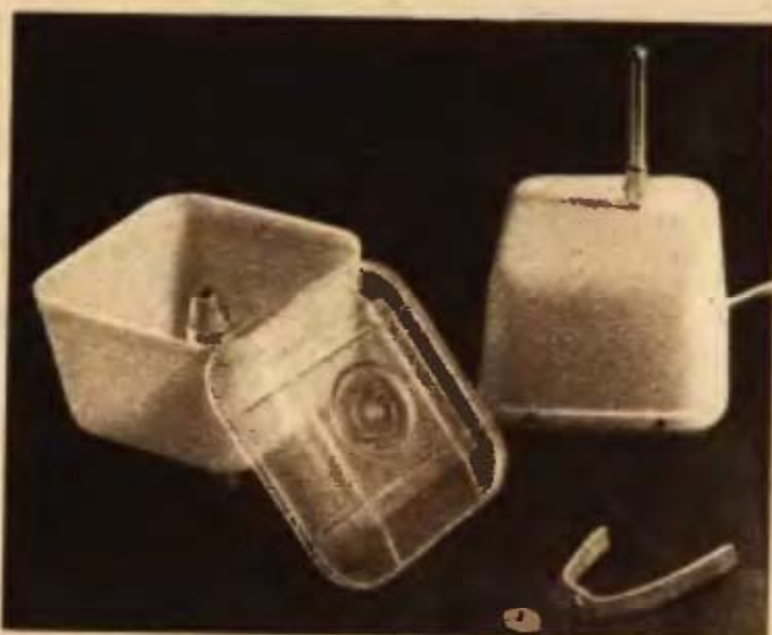
A beépített motor a tengelyhosszabbítóval, valamint a tartály-edény és a keverőlapát
