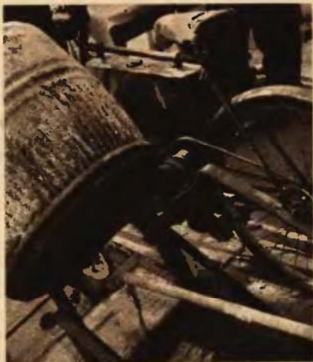
A betonkeverő Dongó-motoros meghajtással
