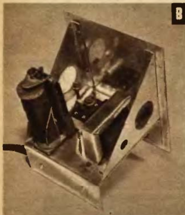
Címkép: Dobozba épített hőfokszabályozó és a forgatógombos hőérzékelő
