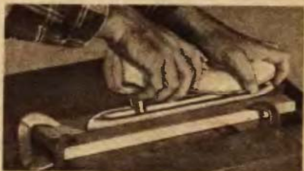
A két vezetőléc közötti hornyban még a műkorcsolya is jól élezhető
