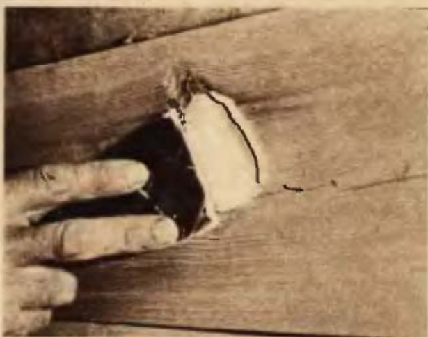
A hibás felületeket alaposan töltjük ki, vonjuk át
