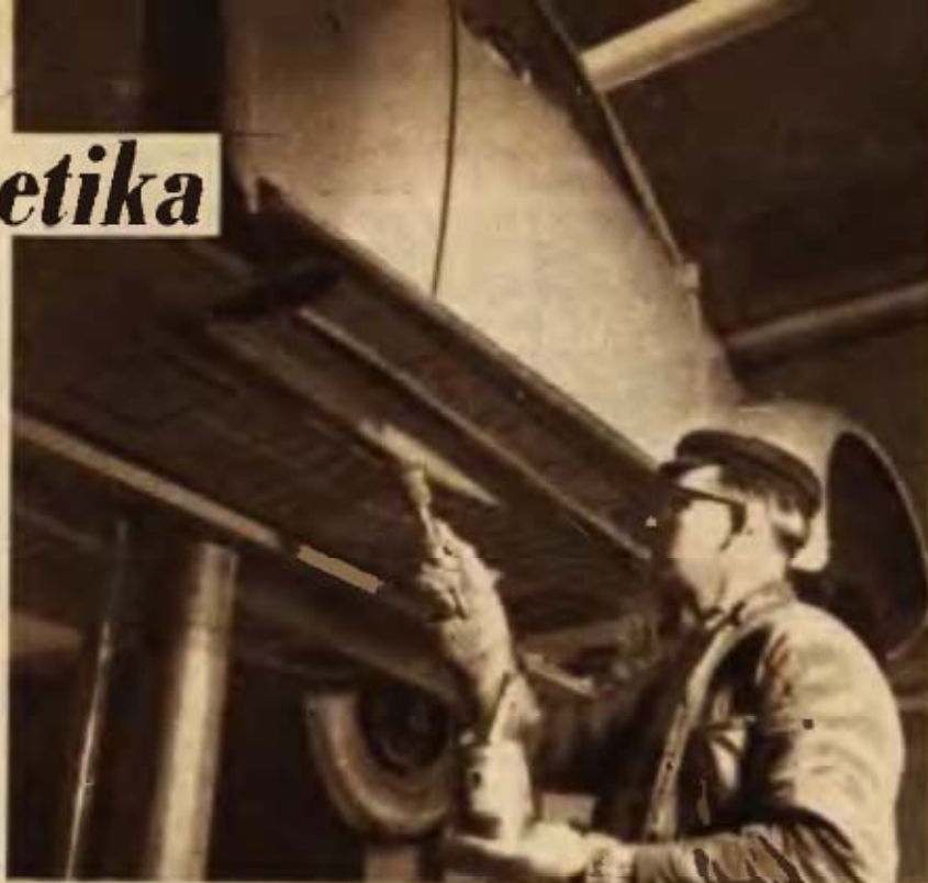
A kocsi alját eredményesen csak alnából, vagy magasemelőn ápolhatjuk. Egyszerű, jó fenékvédő a minium is!
