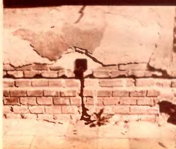
A földeléssel összekötött elektrodák
