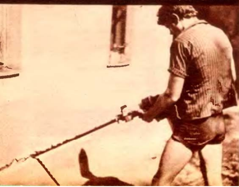
Készül a furat az elektródák (fémrudak) befogadására
