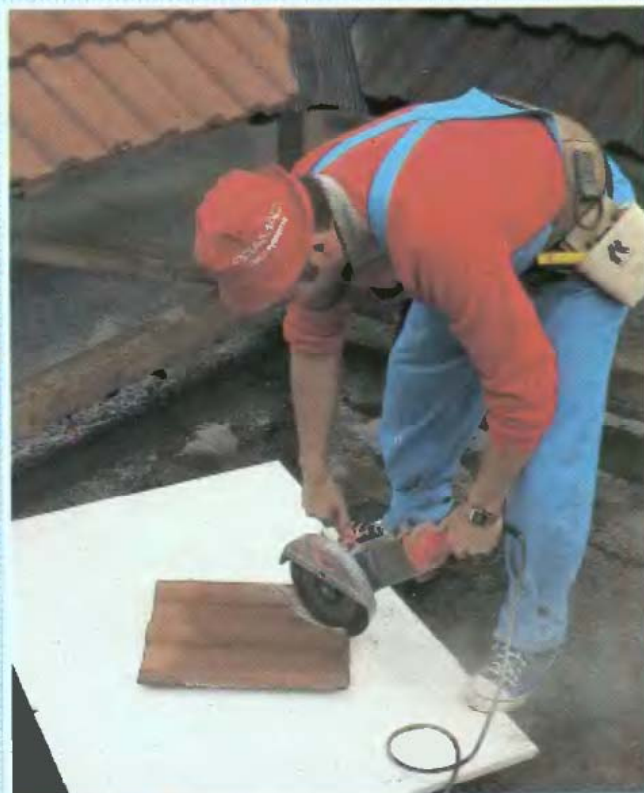
A betoncserep vágása
