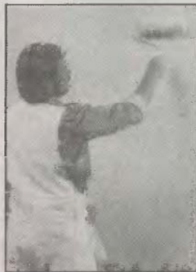
B ábra Ragasztóanyag felvitele a falfelületre
