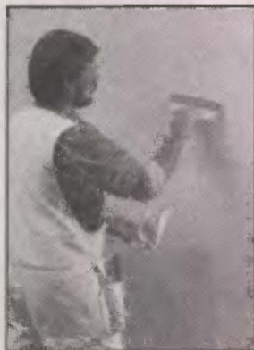
A ábra Falfelület glettelése
