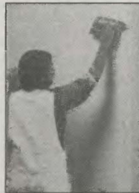
D ábra Burkolólap simítása műanyag lappal
