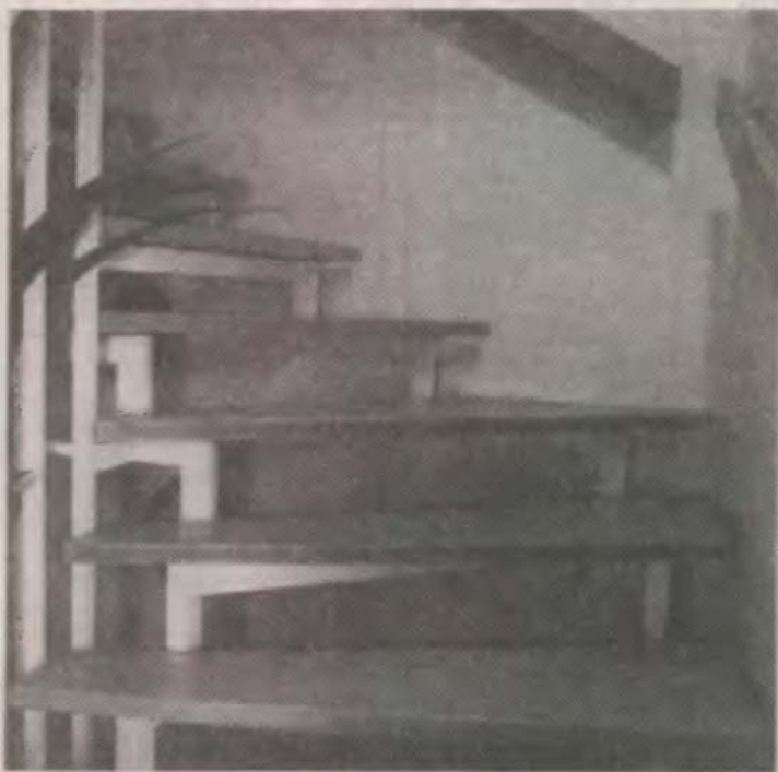
TB jelű: szerelés acélprofilhoz
