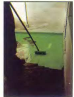
Esztétikai betonpadlóburkolat készítése REOKORR N padlóbevonó anyagból.
