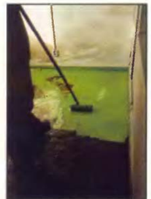
Esztétikai betonpadlóburkotat készítése REOKORR N padlóbevonó anyagból.
