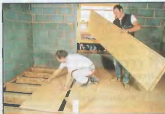
Padlóburkoló anyagként is kiválóan hasznosítható. Beépítésüket megkönnyíti a csaphornyos élkialakítás, a felületkezelést pedig a finomcsiszolt felület. Az OSB-lap kopásálló, hosszú életű és gazdaságos padlóburkoló anyag
