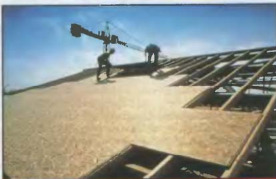
Az OSB-lap időjárás állósága, szilárdsága miatt kiváló építészeti alapanyag. Tetőfedésre, oldalfal burkolatok, zsáuzatok kialakítására egyaránt jól használható
