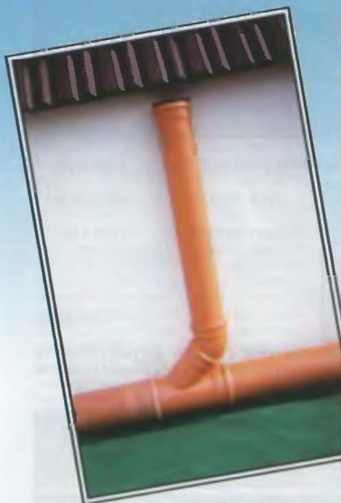
KGEA 45°-os leágazó idom tisztítóidomként. Rossz műszaki megoldás
