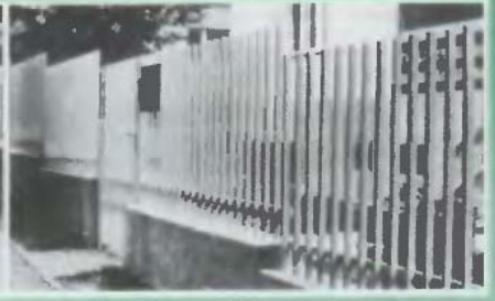
Hevederes rácsszerkezetű kerítés
